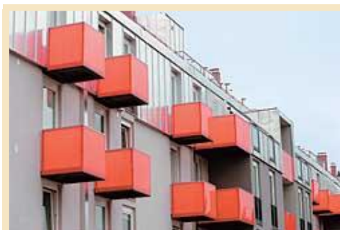
Objekti Drogerije imajo eno nadstropje več, kot kaže njihova zunanja podoba. Del stanovanj na vrhu je tudi neizdelana podstreha, ki jo bodo kupci verjetno preuredili v stanovanjske prostore.
